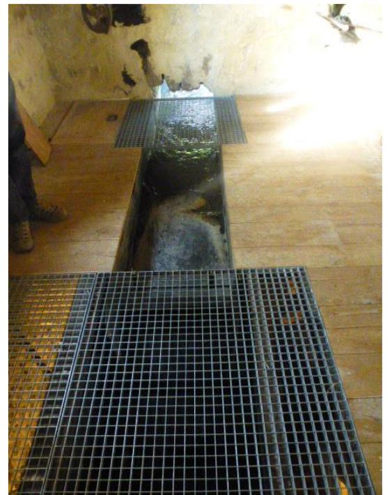
A l'ouverture de la vanne-guillotine, manœuvrée de l'intérieur du moulin, l'eau arrive lentement jusqu'au sommet de la roue de 4 m de diamètre, puis au bout de quelques secondes, le remplissage de trois augets, d'une capacité de 35 litres chacun, amorce le mouvement de la roue, qui transforme la force de l'eau en énergie.
